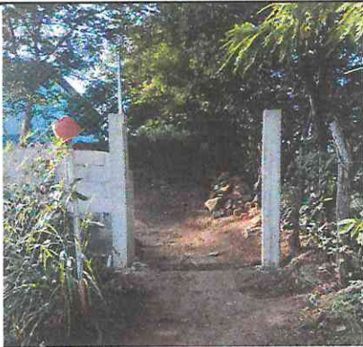
Foto 3: Reconstrucción de dos columnas de 20X20 X 250 de alto
