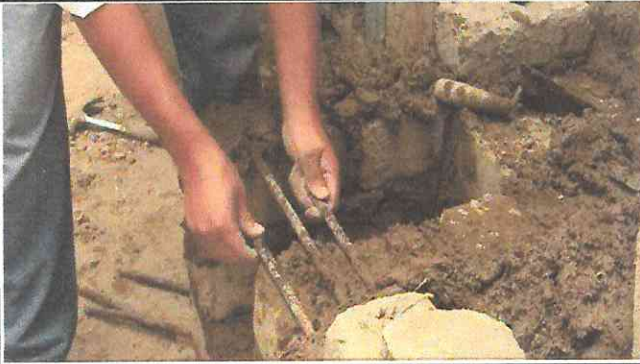
Foto1: Reconstrucción de plancha y chimenea
