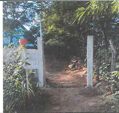
Foto 4: Reconstrucción de portón para ingreso del establecimiento de 1.10 metros por 2.00 metros
