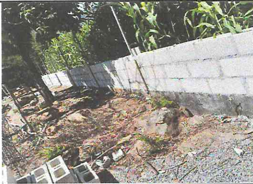
Foto 5: Reconstrucción de muro perimetral que comprende su función de cimentación, levantado de 60 cms de block, colocación de hilada de U fundida y 1.50 mts de malla fundida en U en la parte de abajo, con tubo galvanizado de 1 pulgada horizontal en la parte de arriba y sus respectivos tapones en los tuvos galvanizados
